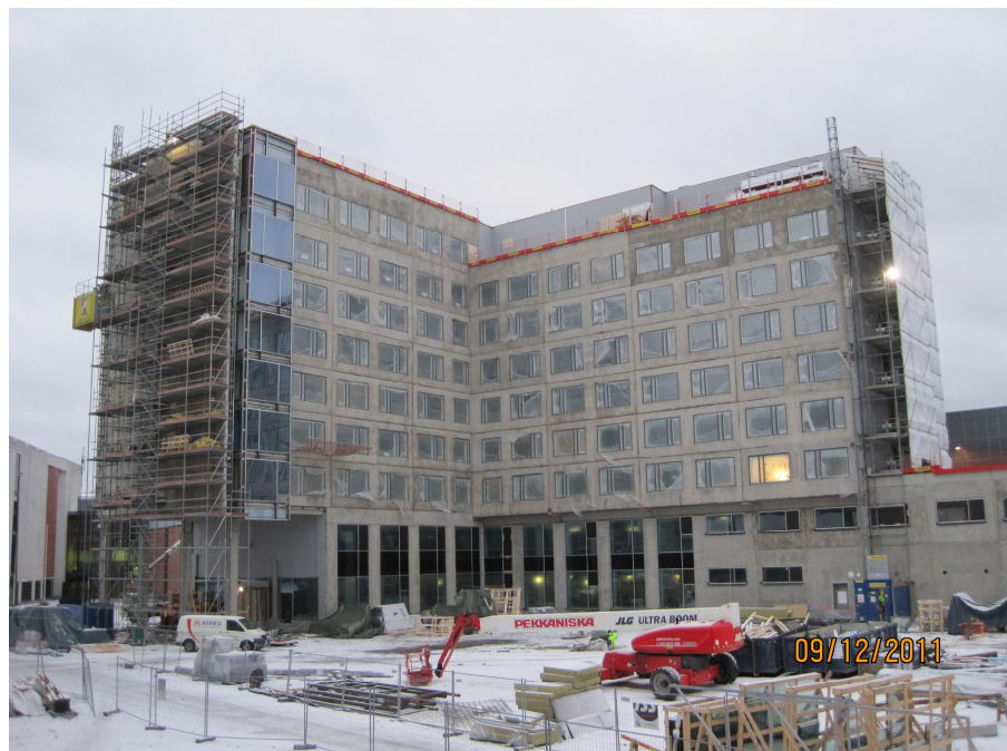
Torninosturi purettu ja suiten- huoneiston lasitus aloitettu.
